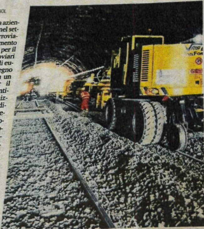
Un cantiere ferroviario gestito dalla Bonaventura Srl
